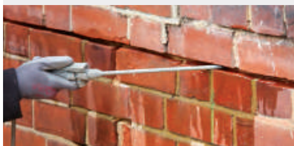
Αφαίρεση των υπολειμμάτων, της σκόνης κτλ. από τους αρμούς και διαβροχή για να επιτευχθεί η απαραίτητη υγρασία πριν από την επισκευή.
