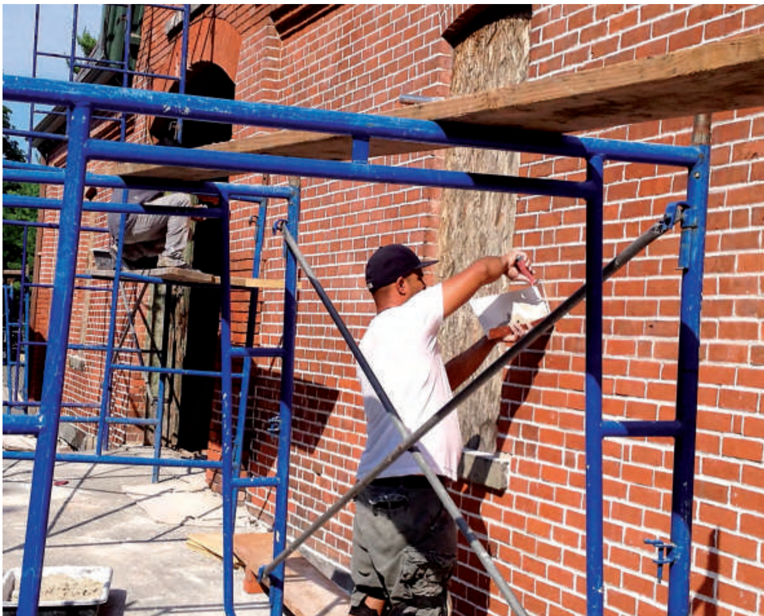
Για την επιδιόρθωση αρμών σε εμφανή οπτοπλινθοδομή με μεγάλο ύψος είναι απαραίτητη η ανάπτυξη του κατάλληλου ύψους ικριώματος, ώστε να είναι εύκολη η πρόσβαση σε όλο το ύψος της τοιχοποιίας.
