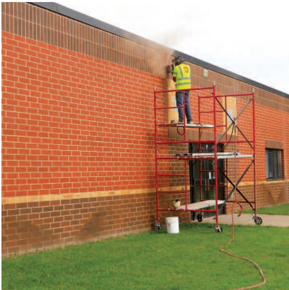
Η χρήση ηλεκτρικών τροχών από έμπειρους τεχνίτες συνιστάται σε περίπτωση επιδιόρθωσης μεγάλων επιφανειών και απαιτεί μεγάλη προσοχή.
