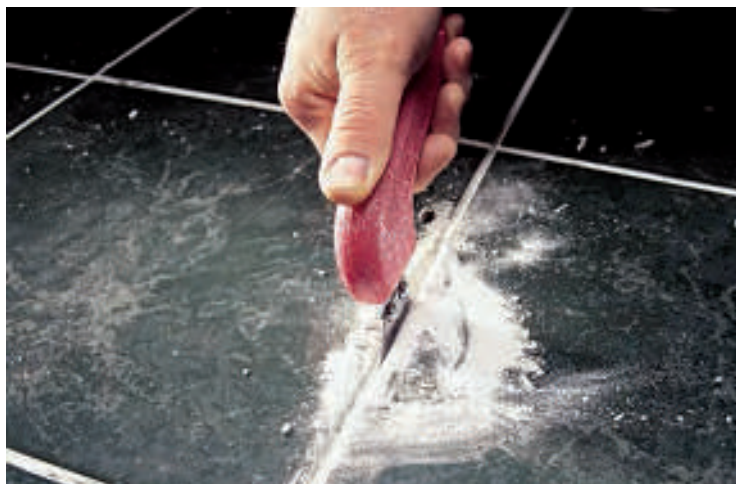
Η αφαίρεση του κονιάματος πρέπει να γίνεται σε ομοιόμορφο βάθος (2 με 2,5 φορές σε σχέση με το πλάτος του αρμού) για να εξασφαλιστεί η επιτυχία της επισκευής.
