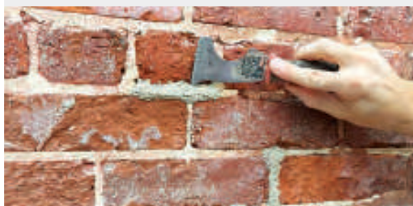
Αφαίρεση του πλεονάζοντος κονιάματος και διαμόρφωση της επιφάνειας με την επιθυμητή υφή 1 - 2 ώρες μετά την εφαρμογή της τελικής στρώσης.
