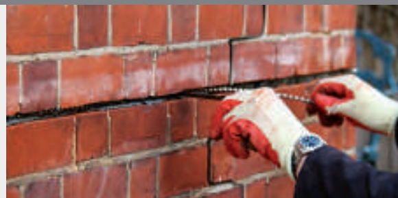
Απομάκρυνση του παλαιού κονιάματος σε ομοιόμορφο βάθος με κατάλληλα εργαλεία.
