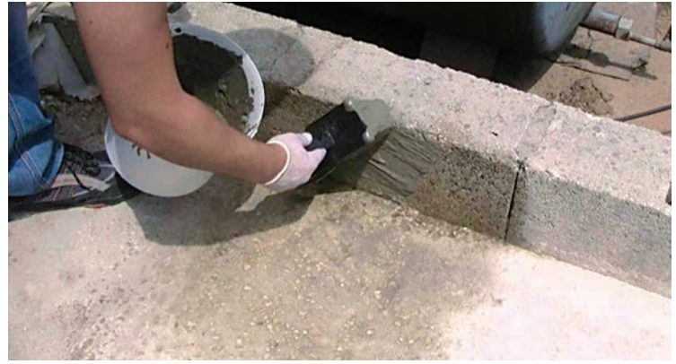
Επάλειψη τσιμεντοειδούς κόλλας με ελαστομερή βελτιωτικά πρόσμεικτα για την επίστρωση πλακιδίων σε εξωτερικό περιβάλλον. Η συγκολλητική ουσία εμφανίζει ανθεκτικότητα στις θερμοκρασιακές μεταβολές, στην υγρασία και στη χημική προσβολή.
