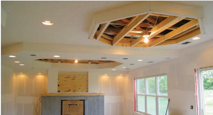
Για την επικόλληση των γύψινων στοιχείων σε ξύλινες βάσεις γίνεται χρήση ελαστομερούς κόλλας μαστίχης από καουτσούκ ή νεοπρένιο.
