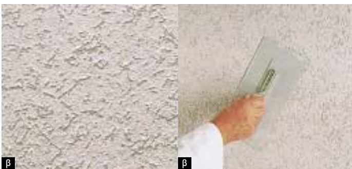
Διάφορα είδη διακοσμητικών επιχρισμάτων: α. Τριφτό με λεπτή άμμο. β. Τριφτό με λεπτή άμμο και αδρανή. γ. Σπατουλαριστό με ελάχιστο ανάγλυφο. δ. Κοκκώδες με διακοσμητικά αδρανή.
