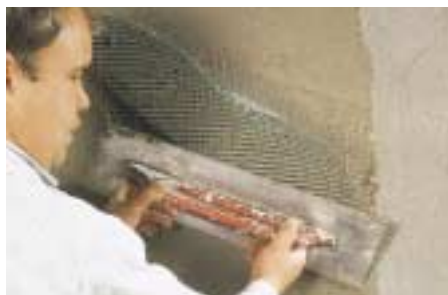
Επισκευή ρηγματωμένου επιχρίσματος με εφαρμογή πλέγματος πριν από την τελική στρώση.
