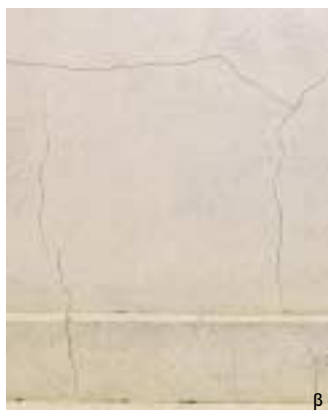
Ρηγμάτωση των επιχρισμάτων: α. Δίκτυο λεπτών ρωγμών στο επίχρισμα. β. Πλατύτερες ρωγμές στο επίχρισμα. γ. Ρωγμές στο επίχρισμα, που ακολουθούν τους αρμούς μεταξύ διαδοχικών δομικών στοιχείων του υπόβαθρου. δ. Ρωγμή που προχωρεί στο βάθος του τοίχου.
