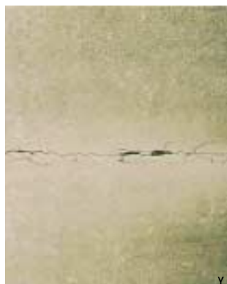
Ρηγμάτωση των επιχρισμάτων: α. Δίκτυο λεπτών ρωγμών στο επίχρισμα. β. Πλατύτερες ρωγμές στο επίχρισμα. γ. Ρωγμές στο επίχρισμα, που ακολουθούν τους αρμούς μεταξύ διαδοχικών δομικών στοιχείων του υπόβαθρου. δ. Ρωγμή που προχωρεί στο βάθος του τοίχου.
