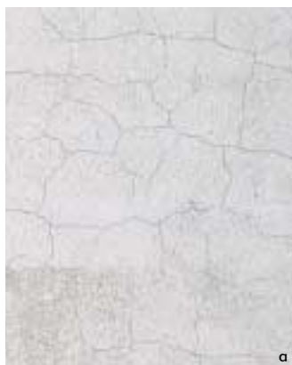
Ρηγμάτωση των επιχρισμάτων: α. Δίκτυο λεπτών ρωγμών στο επίχρισμα. β. Πλατύτερες ρωγμές στο επίχρισμα. γ. Ρωγμές στο επίχρισμα, που ακολουθούν τους αρμούς μεταξύ διαδοχικών δομικών στοιχείων του υπόβαθρου. δ. Ρωγμή που προχωρεί στο βάθος του τοίχου.
