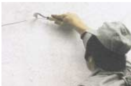
Διάνοιξη ρωγμής στο επίχρισμα και στεγανοποίησή της με ειδικό στόκο.
