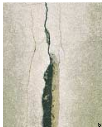
Ρηγμάτωση των επιχρισμάτων: α. Δίκτυο λεπτών ρωγμών στο επίχρισμα. β. Πλατύτερες ρωγμές στο επίχρισμα. γ. Ρωγμές στο επίχρισμα, που ακολουθούν τους αρμούς μεταξύ διαδοχικών δομικών στοιχείων του υπόβαθρου. δ. Ρωγμή που προχωρεί στο βάθος του τοίχου.
